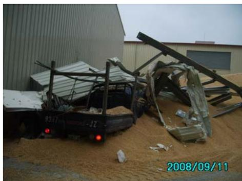
圖 3、外牆鍍鋅鋼承板受拉扯撕裂
