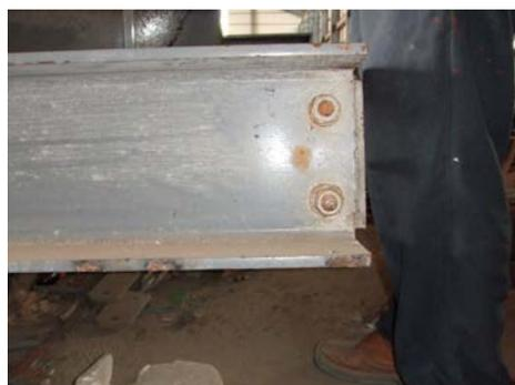
圖 5、柱與梁接頭處破壞現況
