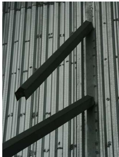
圖 2、鋼梁接頭處產生拉力破壞
