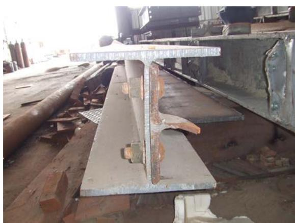
圖 13、SG1H250X250X 9X14 端部未開槽及未銲接正面現況
