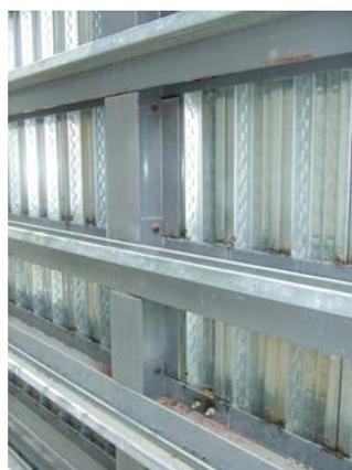
圖 8 外牆鍍鋅鋼承板  $T_w=1.5mm$
