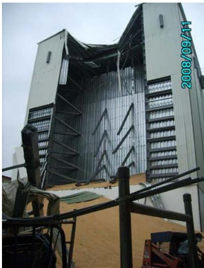
圖 1、研究案例鋼構廠房結構體坍塌損壞
