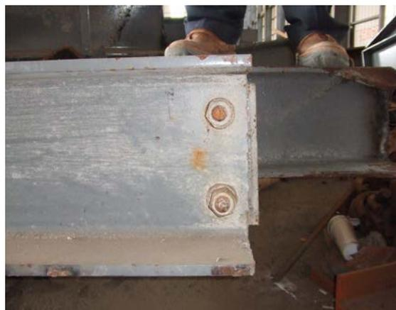
圖 14、SG1H250X250X 9X14 端部未開槽及未銲接側面現況
