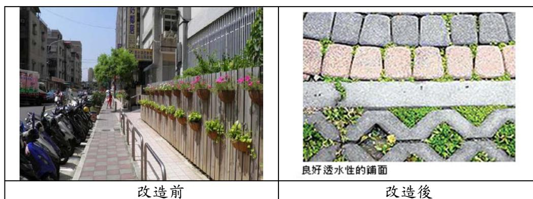
圖4、社區人行步道改造成透水鋪面示意圖
