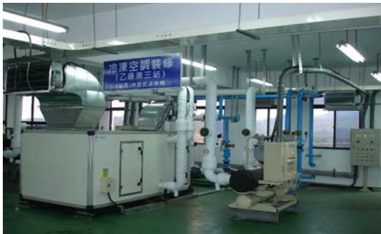
圖 3、空調箱相關系統實體連結圖
