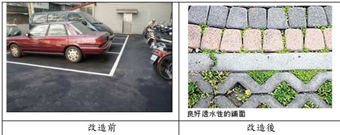
圖1 改造成透水性鋪面示意圖
