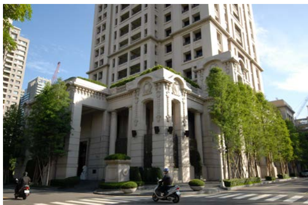
圖 3、建築外立面石材運用
